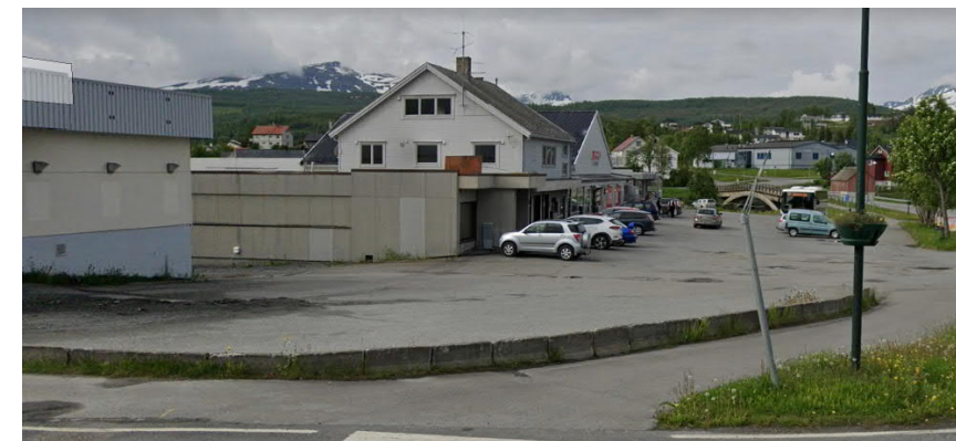
Figur 34: Område benyttet til torg (sørlige del) blir også brukt som p-plass.
