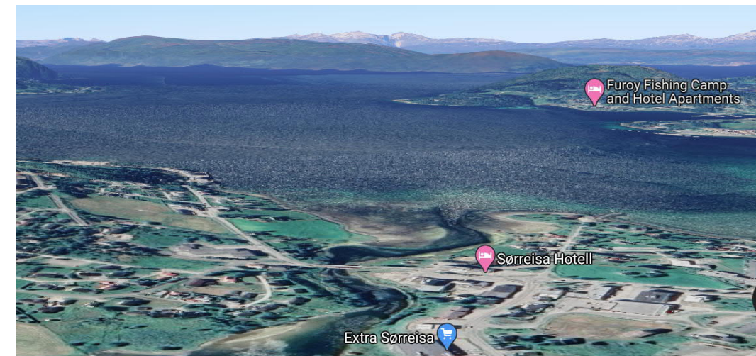
Figur 18: tettstedet Sørreisa åpner seg mot vest og Reidfjorden (Google Maps)
