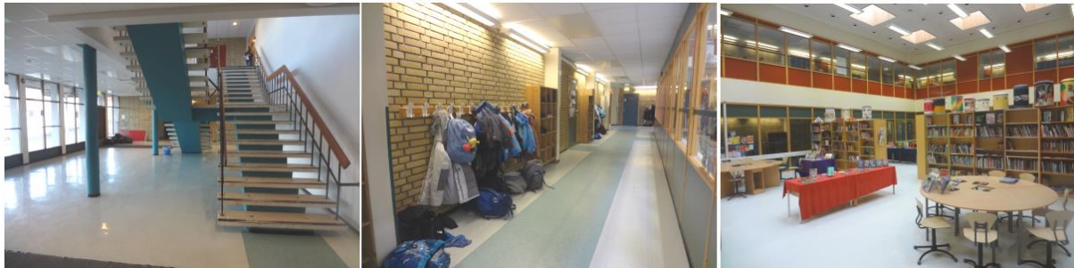
Figur 6: Bilde av hovedtrapp i vestibyleområdet, korridor fra vestibyle mot sør langs biblioteket. Biblioteket har transparente glassfelt mot gangarealene i begge etasjer.
